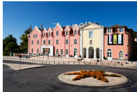
6. Cascais Cultural Center (2000).
